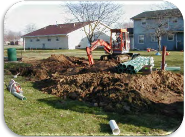
Mini Storm Sewer Installation - Backyard
