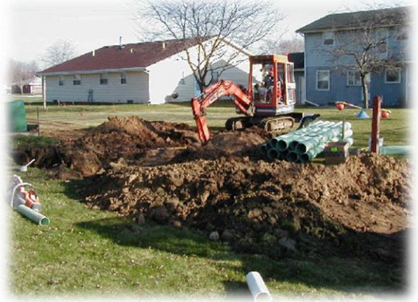
Mini Storm Sewer Installation - Backyard
