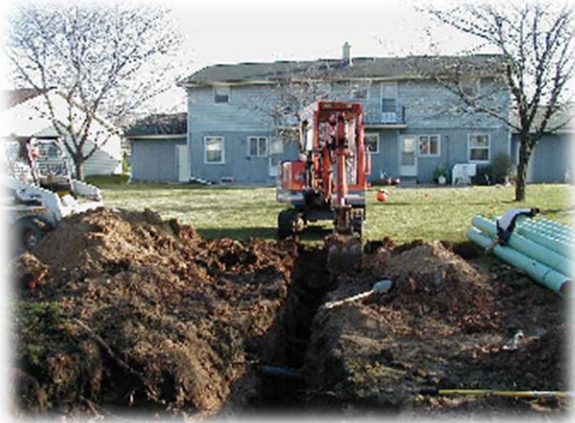
Mini Storm Sewer Installation - Backyard
